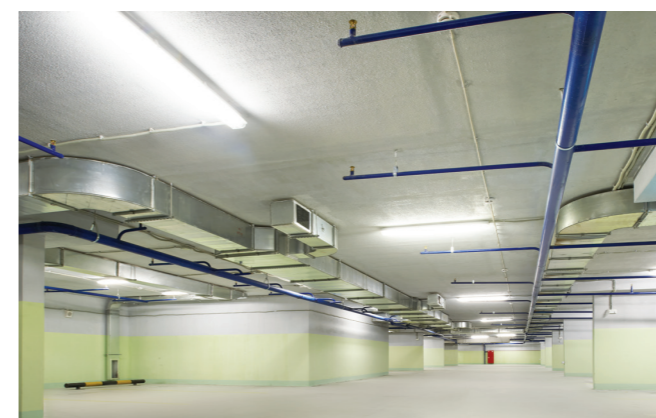
Подземная двухуровневая автостоянка, г. Королев
