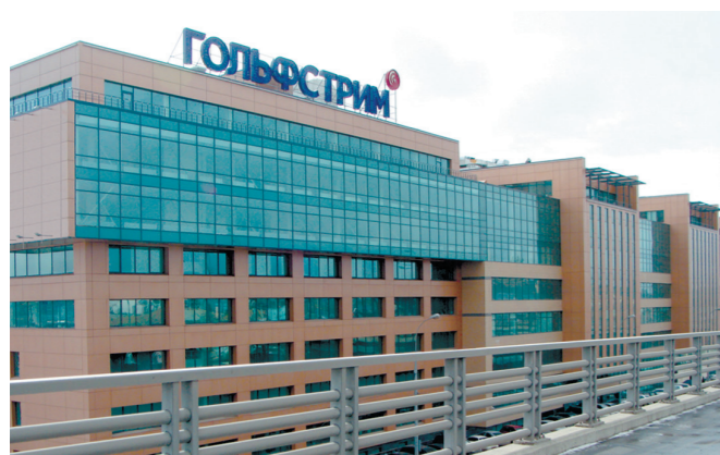
Офисный центр «Гольфстрим», г. Москва
