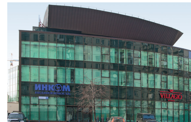
Офисный центр компании «ИНКОМ», г. Москва
